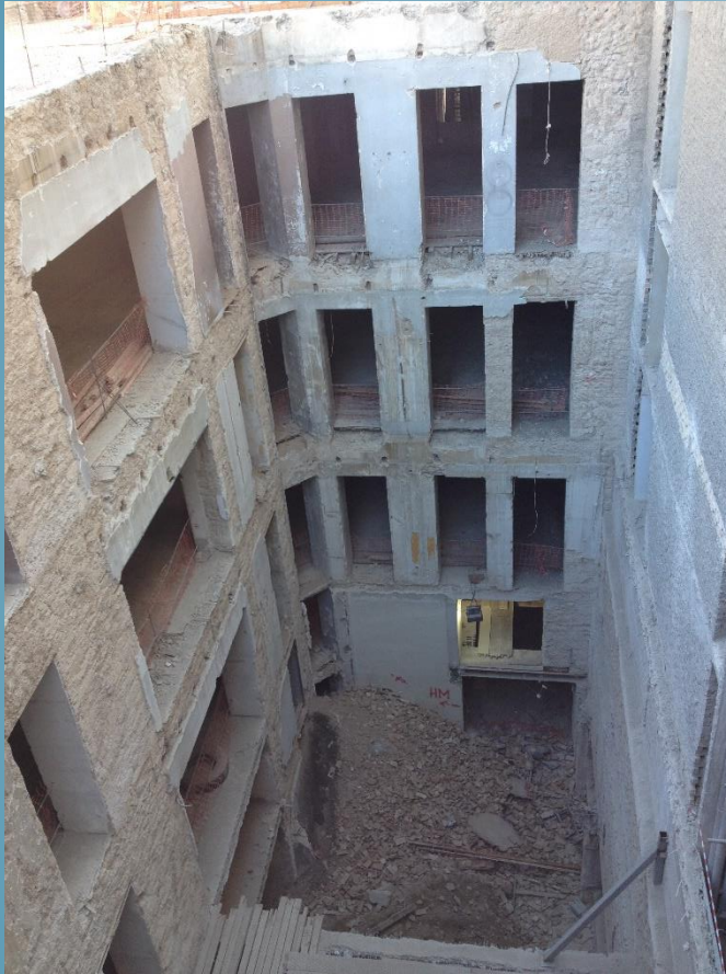
Πριν την τοποθέτηση μεταλλικών στοιχείων
