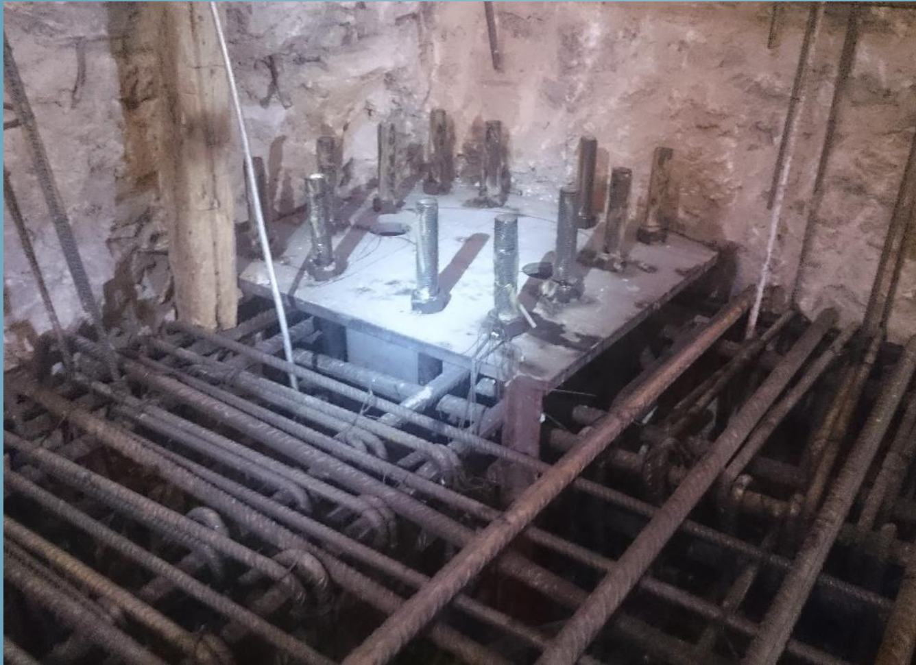
Τοποθέτηση οπλισμών - αγκυρίων
