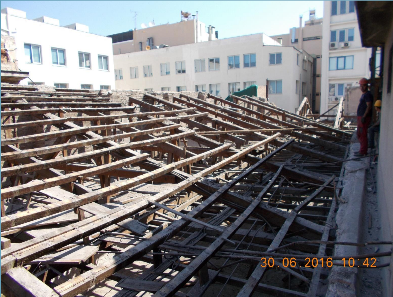
Η ξύλινη στέγη του κτιρίου.
