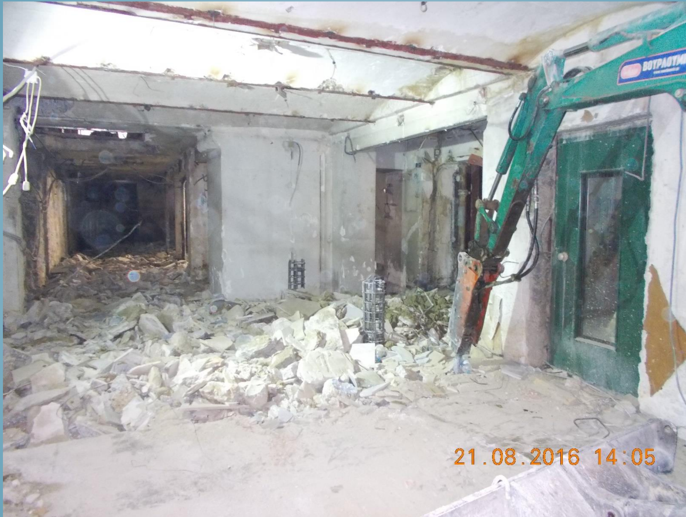
Καθαίρεση πλάκας δαπέδου υπογείου
