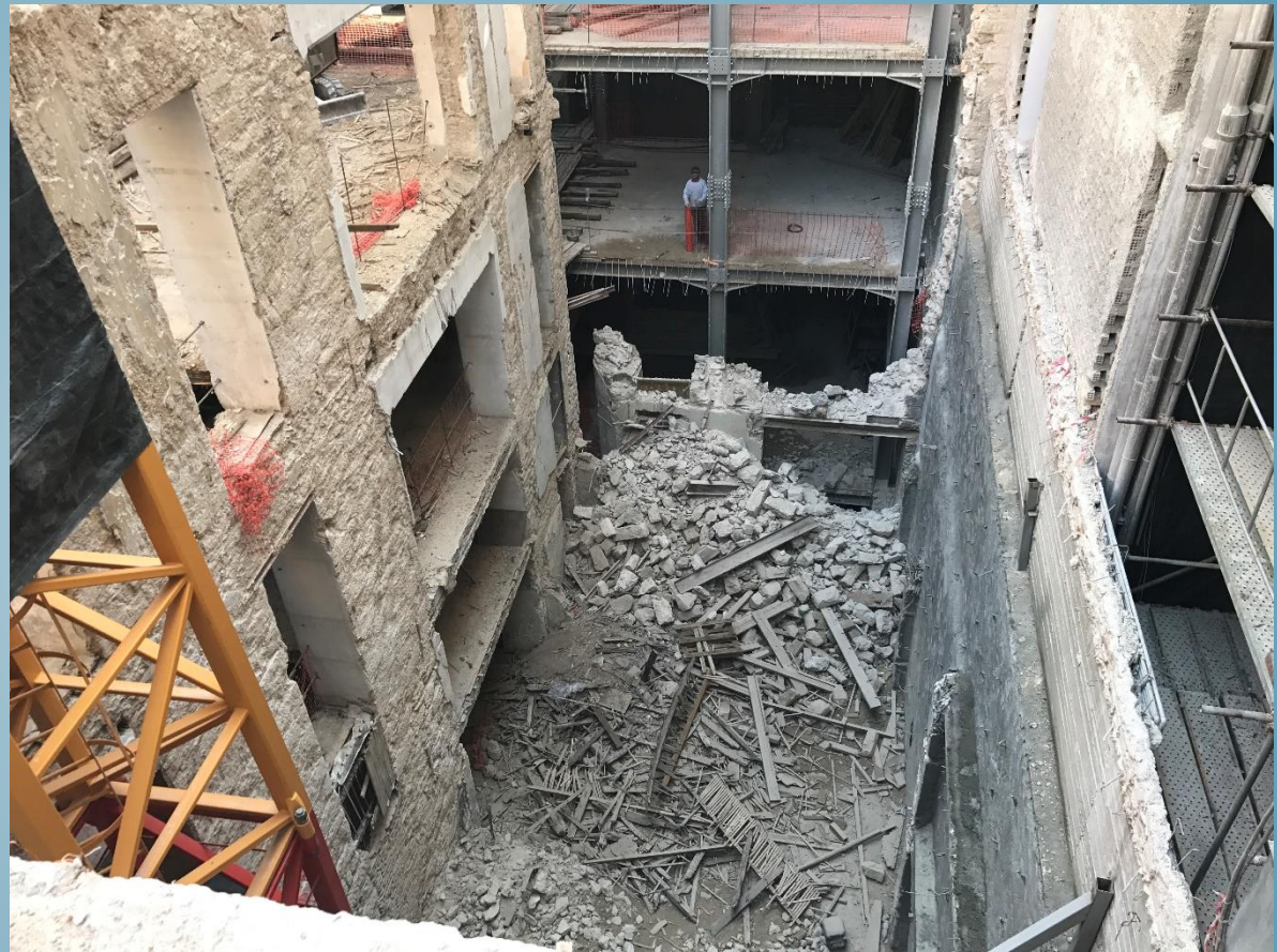
Μετά την τοποθέτηση μεταλλικών στοιχείων. Σταδιακή καθαίρεση λιθοδομών.
