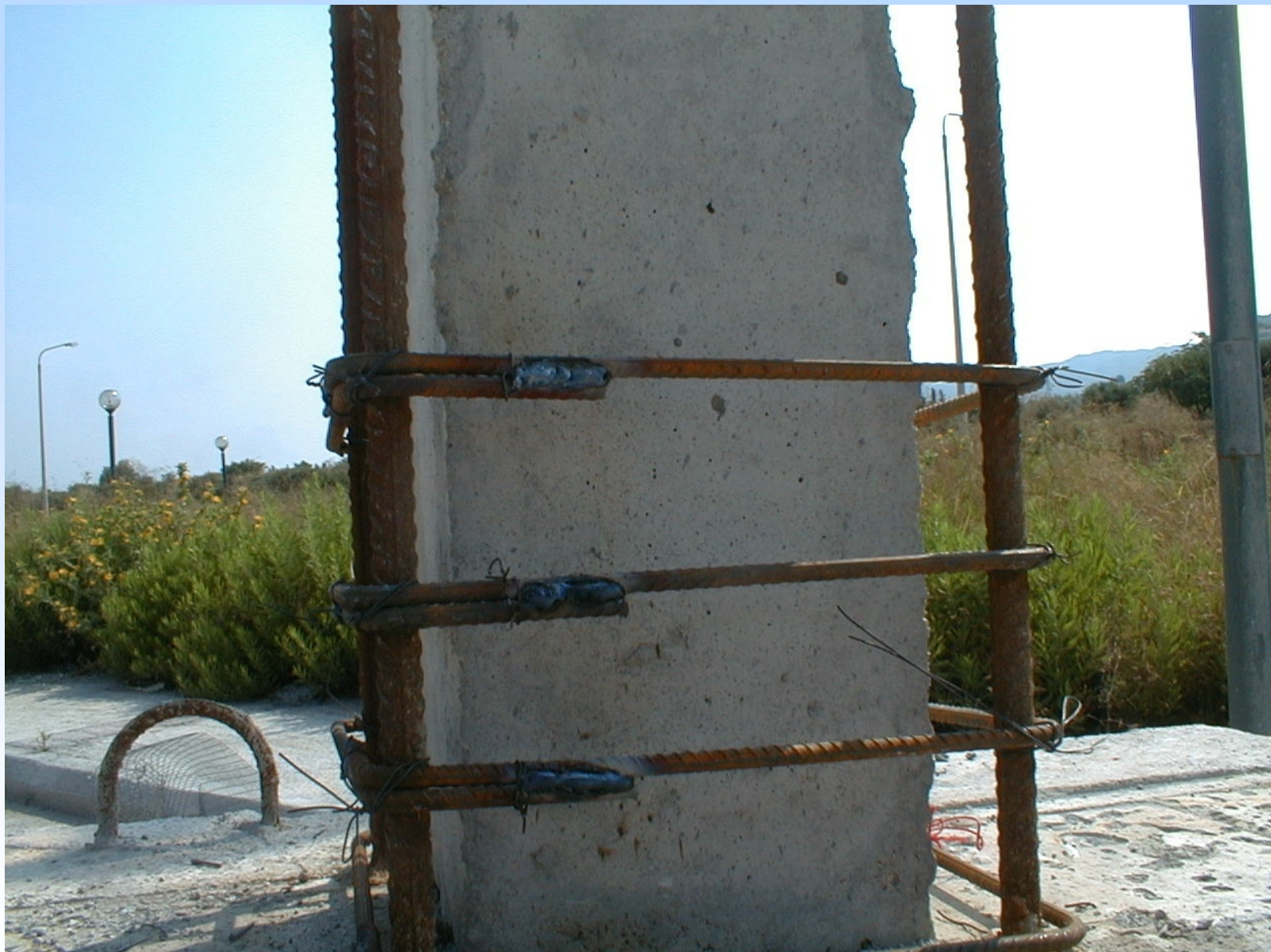
Ηλεκτροσυγκόλληση Άκρων Συνδετήρων Μανδύα
