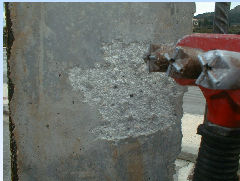
Προετοιμασία Επιφάνειας με Αεροματσάκονο
