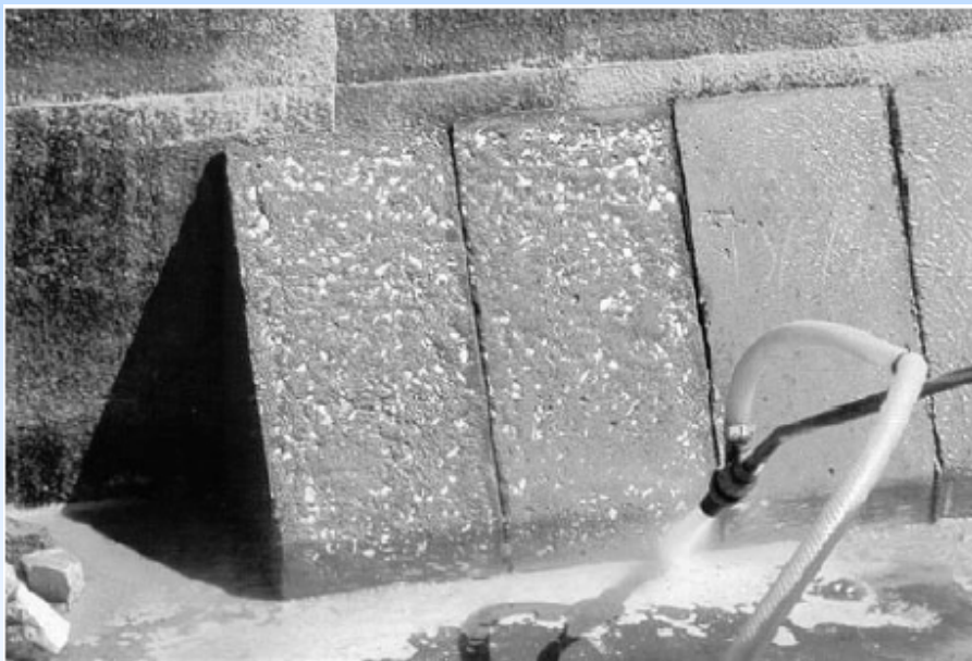
Εκτράχυνση με Αμμοβολή
